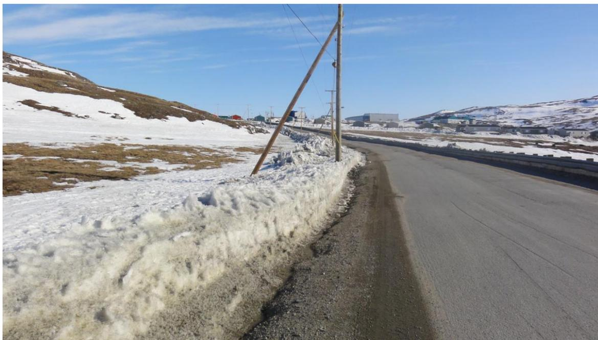
**Figure 11 : Accumulation de neige le long d'un remblai, Salluit, Québec (Allard, 2016)**
