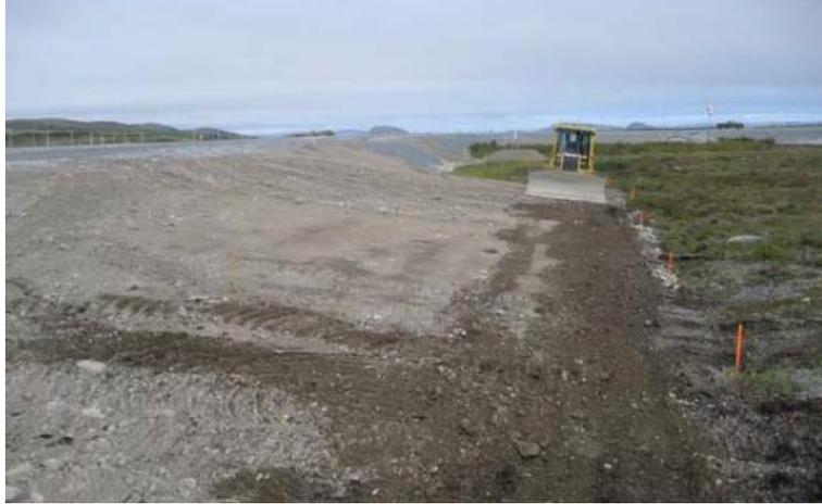
**Figure 31 : Adoucissement de la pente à la section d'essai de Tasiujaq, été 2007 (Jørgensen et Doré, 2009)**
