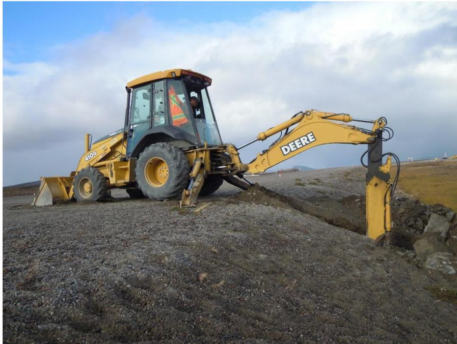
**Figure 43 : Excavation du remblai en vue de la mise en place du TAC2598 au chaînage 5+515 m de la piste d'atterrissage de Tasiujaq, septembre 2014**
