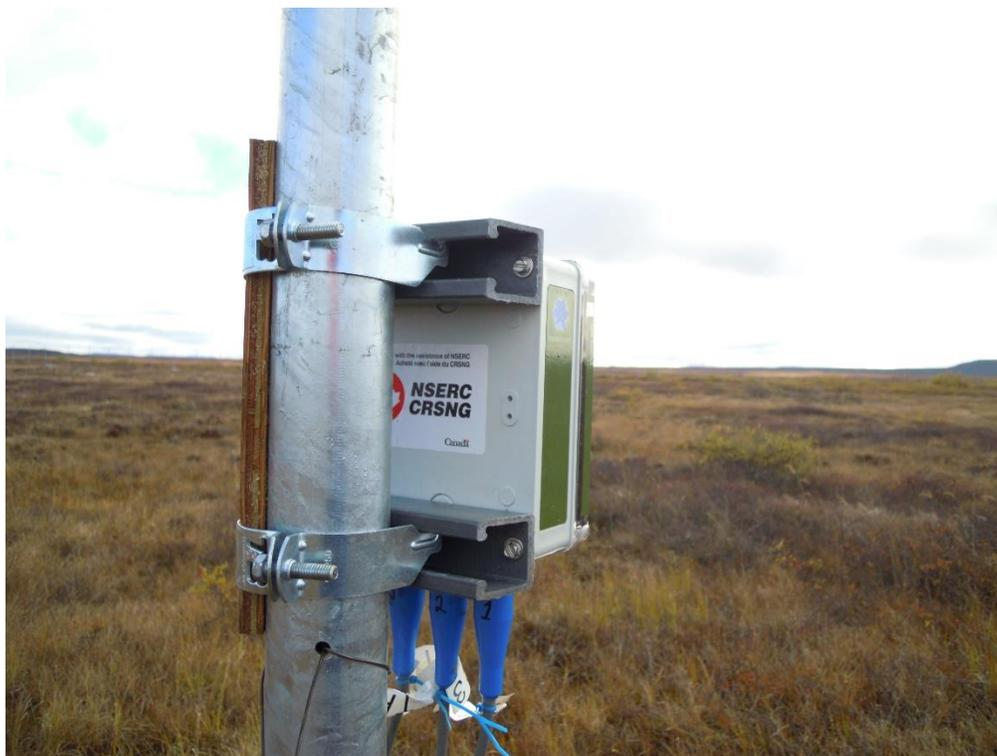
**Figure 40 : Montage du système d'acquisition et de transition D405 de BeadedStream au chaînage 5+515 m de la piste d'atterrissage de Tasiujaq, septembre 2014**
